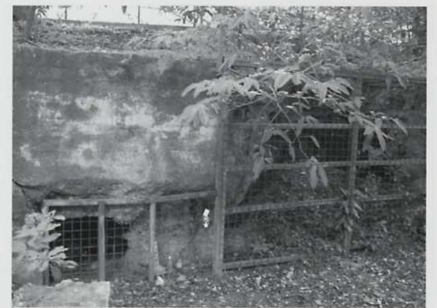
爆撃によって破壊したトーチカ
