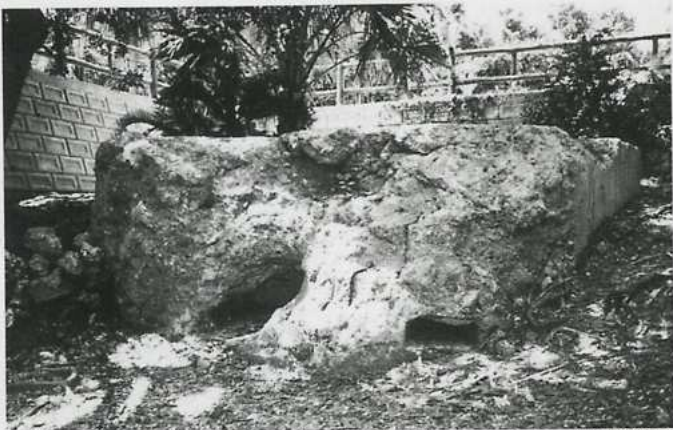
守備隊のトーチカ（砲撃により正面が破壊されているが、右側の銃眼はそのまま残っている。）
