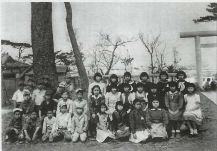
垣花小学校卒業写真（後方に第2鳥居、社務所が写っている）
